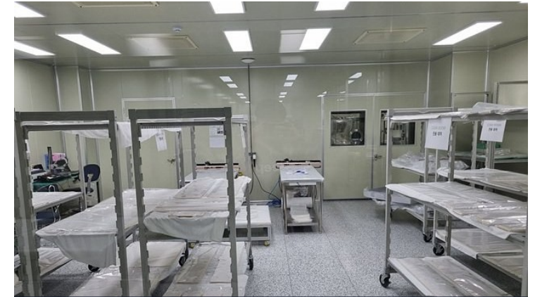
Clean Room 1,000 급 — 최종 세정 · 검사 · 포장
